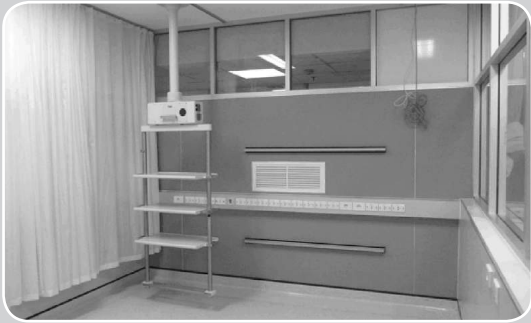
รูปแสดงตำแหน่งหน้ากการระบายอากาศที่หัวเตียงผู้ป่วย
