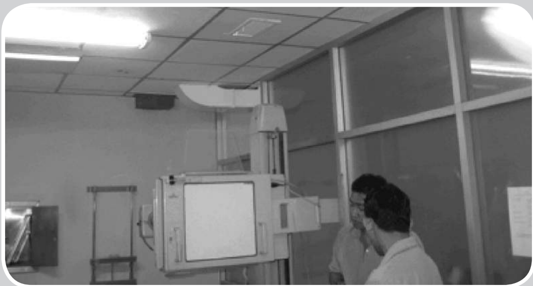
รูปแสดงตัวอย่างห้องฉายรังสีที่ติดตั้งหน้ากากระบายอากาศตำแหน่งที่ผู้ป่วยยืน
