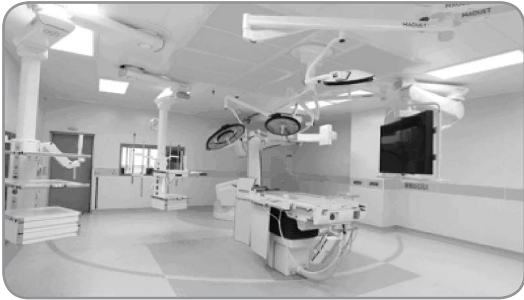
รูปแสดงการจ่ายอากาศสะอาดครอบคลุมบริเวณพื้นที่ผ่าตัด
