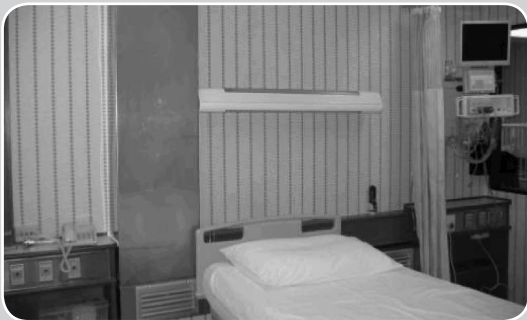
รูปแสดงตำแหน่งหน้ากากระบายอากาศที่หัวเตียงผู้ป่วย
